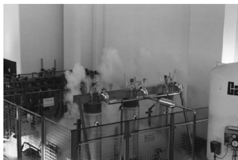
Рис. 2 – Індуктивний обмежувач струму (підстанція Kraftwerk am Lontsch)
